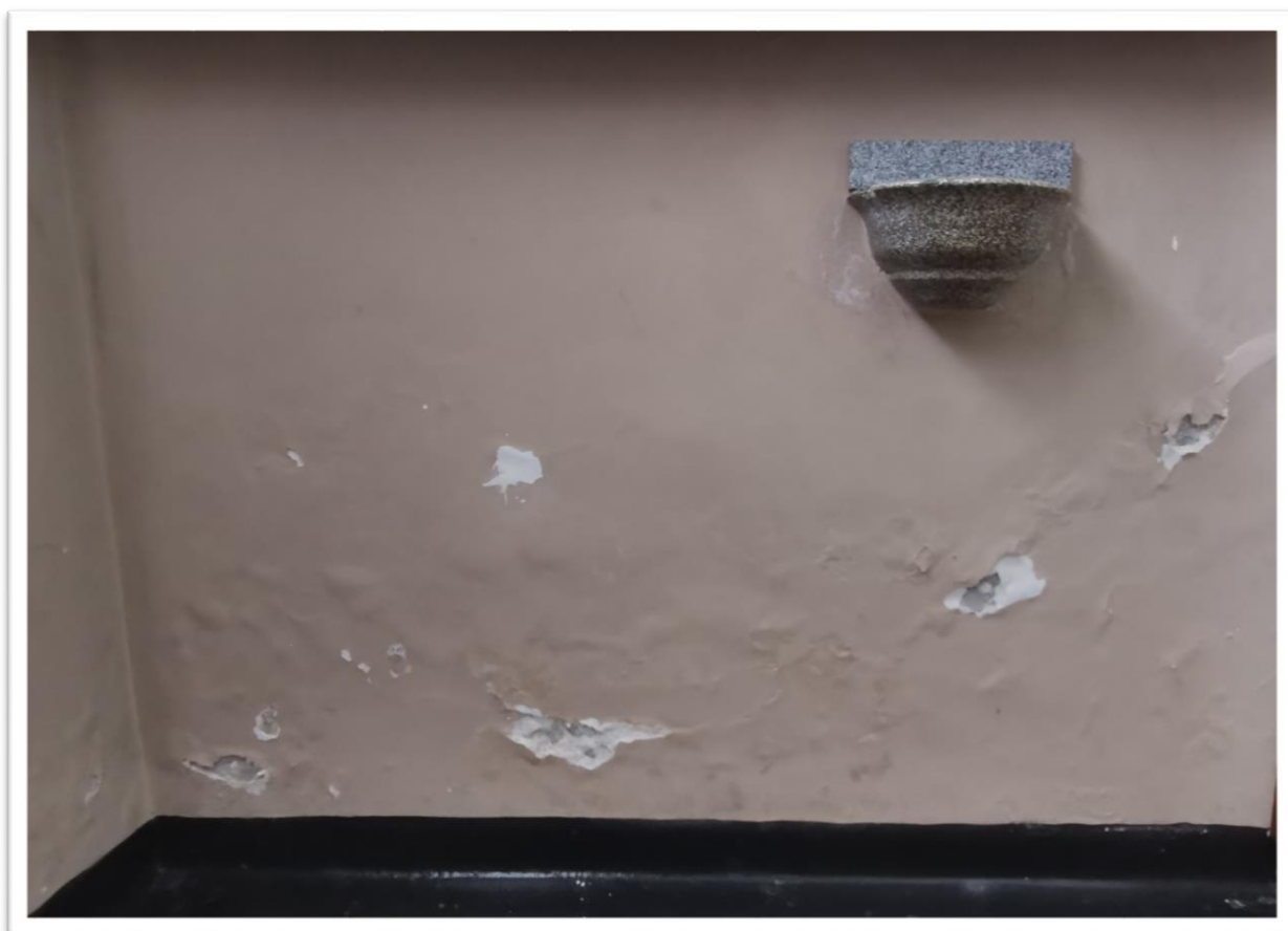
Fot. nr 6. Problem z utratą adhezji i kohezji zewnętrznych warstw malarskich, w wyniku kapilarnego podciągania wilgoci.
