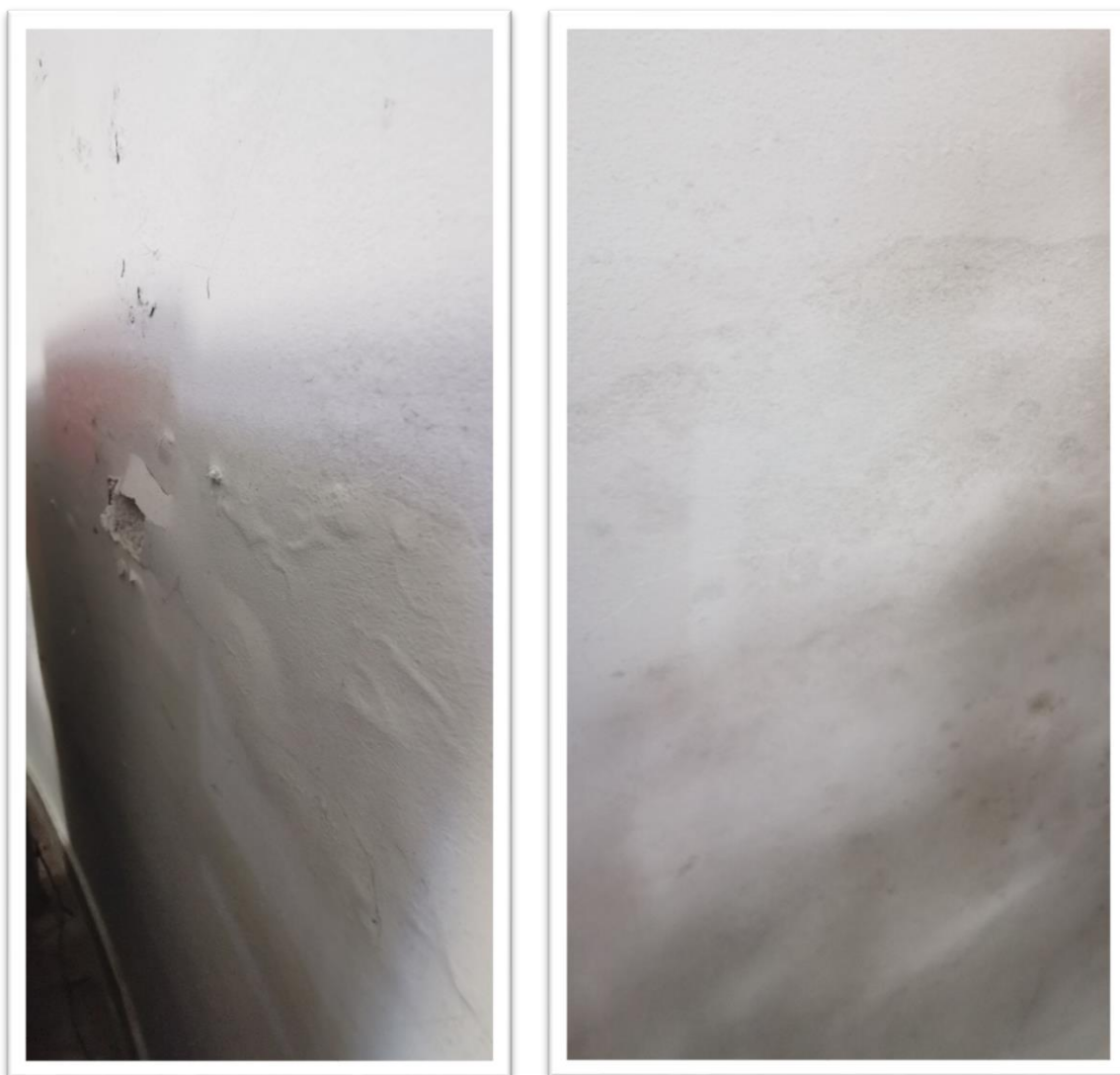
Fot. nr 4, 5. Zawilgocenie ścian absydy. Zbliżenie na partie zainfekowane przez mikroorganizmy oraz wykwity soli podciąganych kapilarnie
