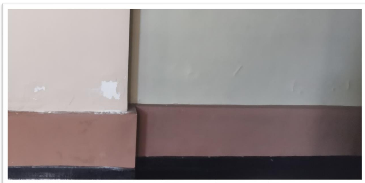
Fot. nr 7. Ściana boczna kościoła, strona prawa. Widoczne odpryski farby wynikające z kapilarnego podciągania wilgoci
