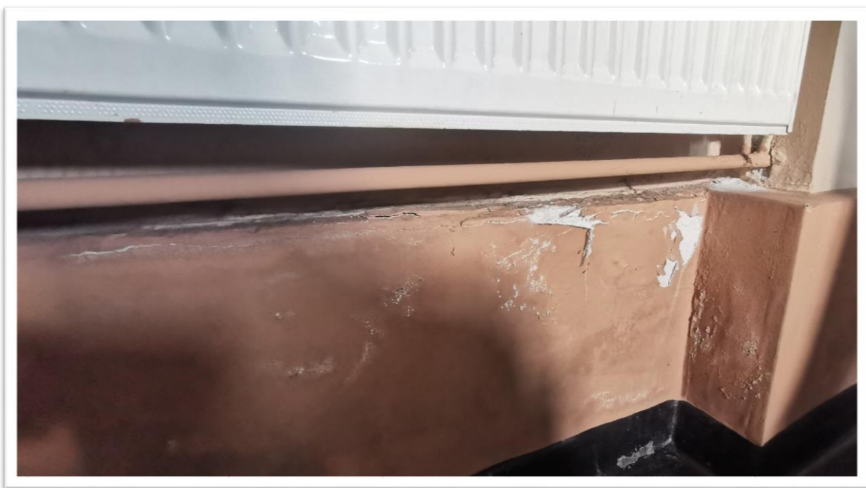
Fot. nr 8. Boczna ściana kościoła, strona lewa. Uwidocznione problemy wynikające z zawilgocenia
